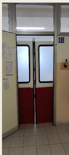
VISTA DALL'ESTERNO DELLA PORTA TERMINATA
